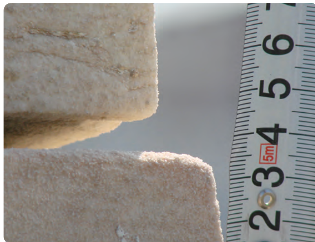
Ζαχαροποίηση και όξινη προσβολή μαρμαρινής επιφάνειας λόγω ατμοσφαιρικής ρύπανσης. Λεπτομέρεια από το κτίριο-μνημείο της Ακαδημίας Αθηνών.
