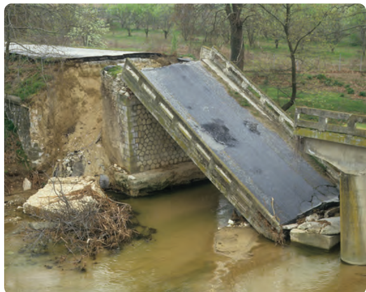
Κατάρρευση γέφυρας μετά από πλημμύρα (Λαγκαδάς).
