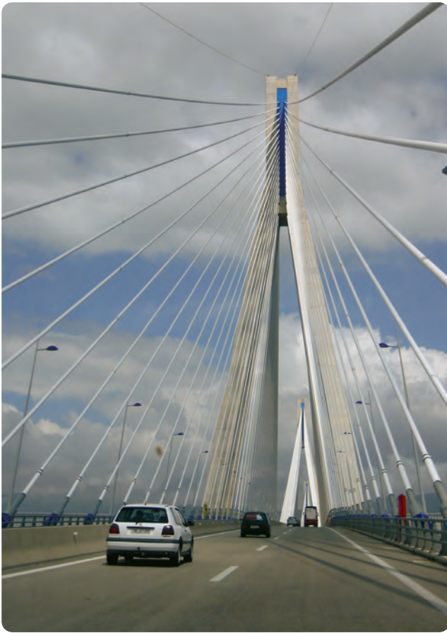
Η γέφυρα Ρίου-Αντιρρίου.
