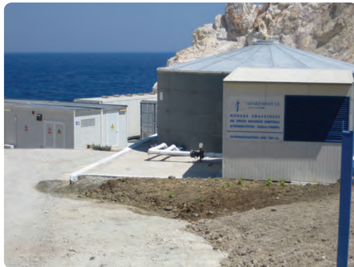
Μονάδα αφαλάτωσης στη Μήλο.
