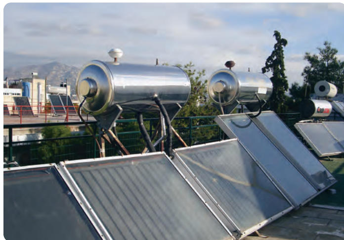
Ηλιακοί θερμοσίφωνες σε ταράτσα πολυκατοικίας.
