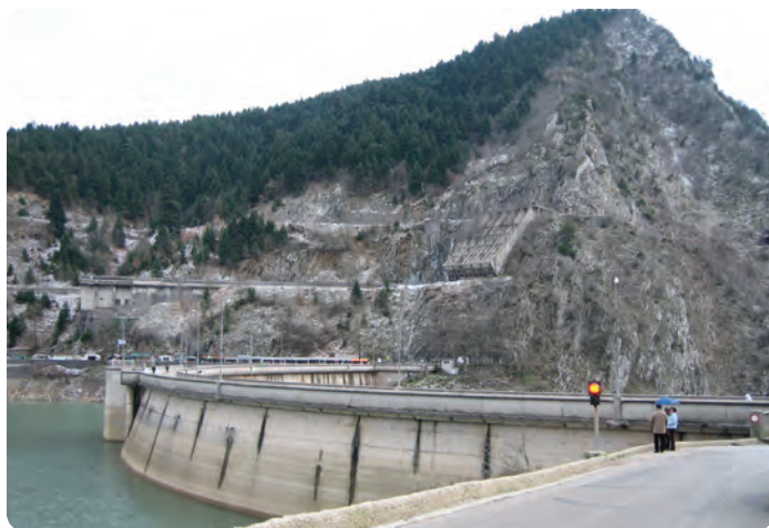
Φράγμα Ταυρωπού (Ν. Καρδίτσας).
