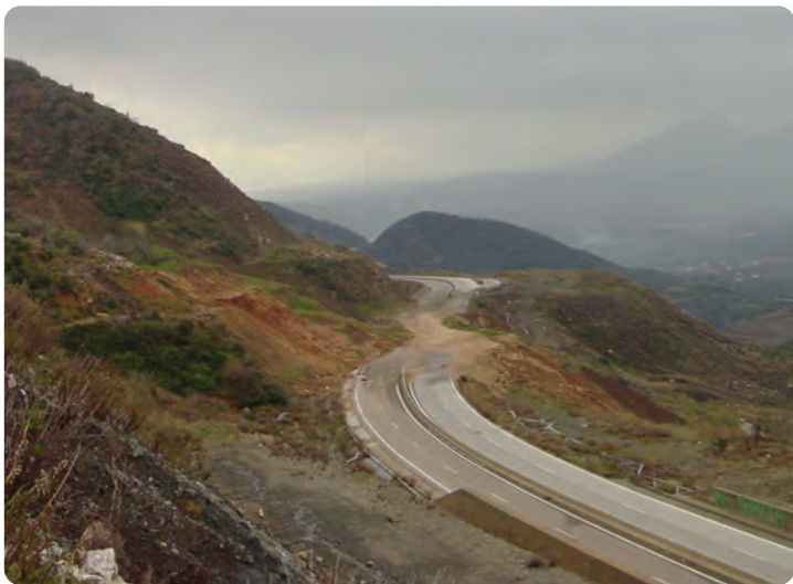
Κατολίσθηση στην Τσακώνα (Εθνική οδός Μεγαλόπολης-Καλαμάτας).
