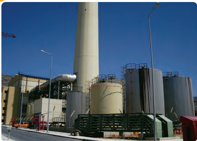
Ο σταθμός της Δ.Ε.Η. στον Αθρινόλακο Κρήτης λειτουργεί με πετρέλαιο.
